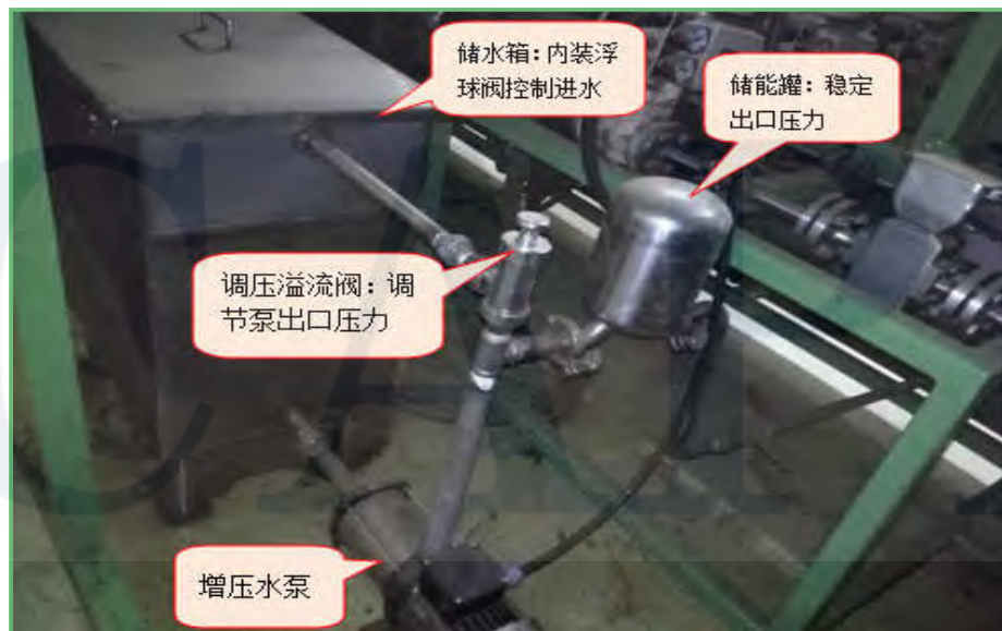
图7 增压稳压系统现场安装图片
