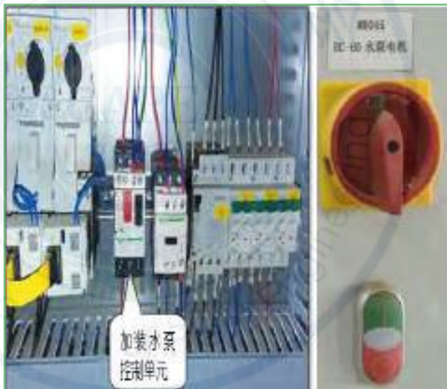
图8 电控系统现场安装图片
