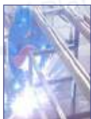
下料焊接支架
