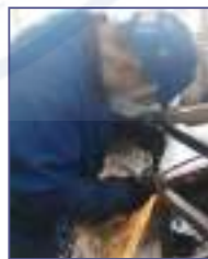
支架焊接点打磨
