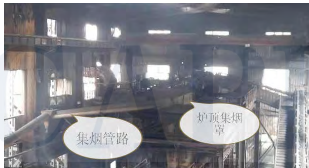
炉顶加设集烟装置
