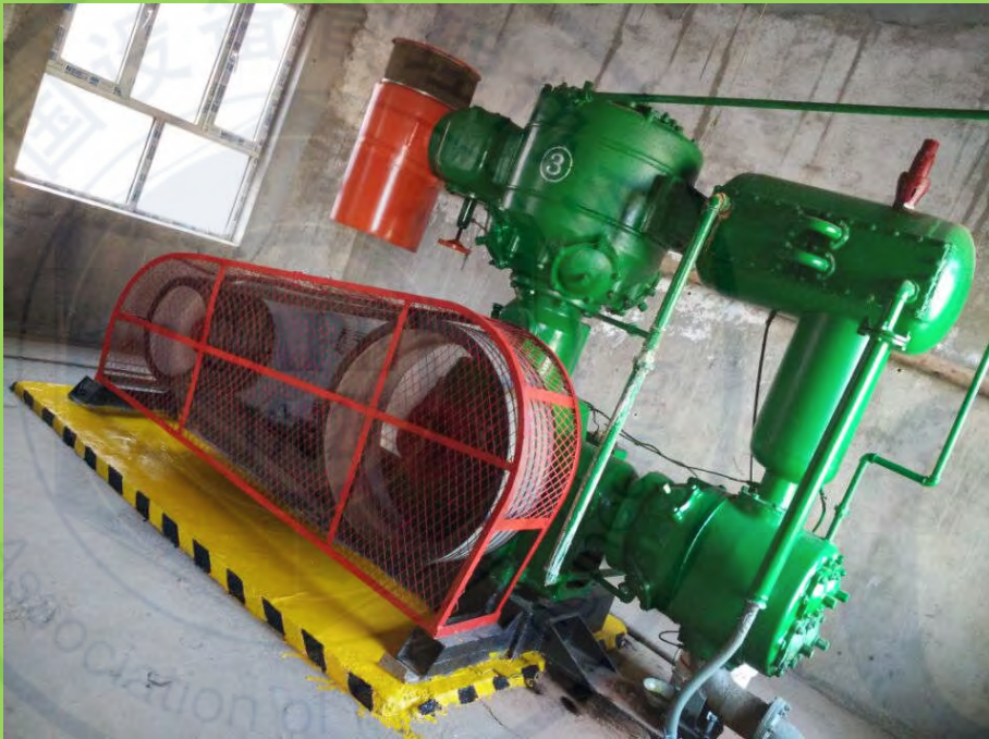
活塞空压机 L22/7 排气量：22m 3 /min 风压：0.7Mpa 功率：132KW
