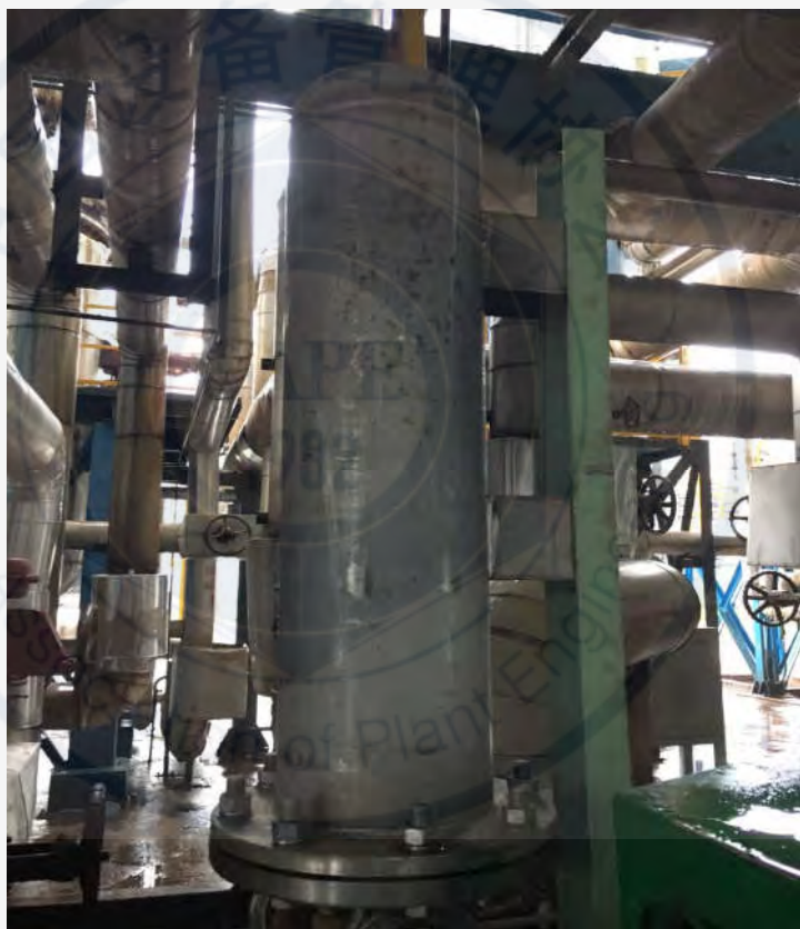
更换上新冷却器
