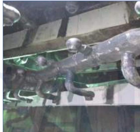
优化喷淋层结构，提高单层浆液覆盖率在300%以上
