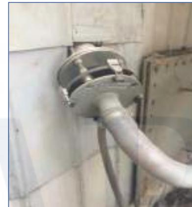
采用低量程CEMS分析仪、超声波烟气流量计、抽取加热红外分析烟尘仪。
