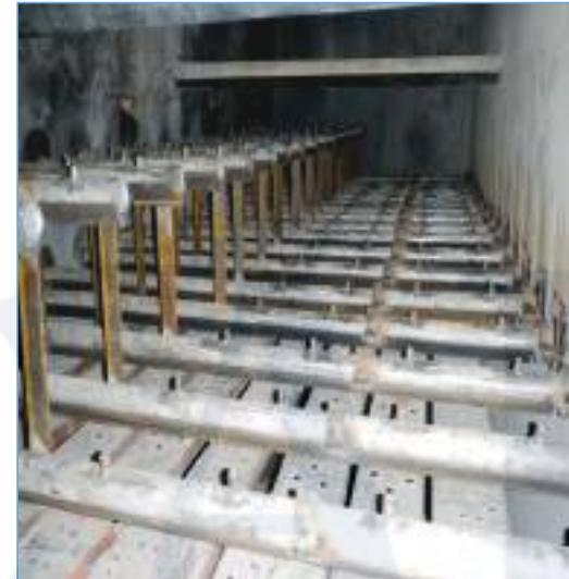
通过增加两层催化剂及加大喷氨量，脱硝效率由原来的83% 提高到95%。
