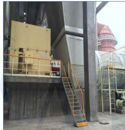
单台引风机电机功率由6000KW增加到7400KW。
