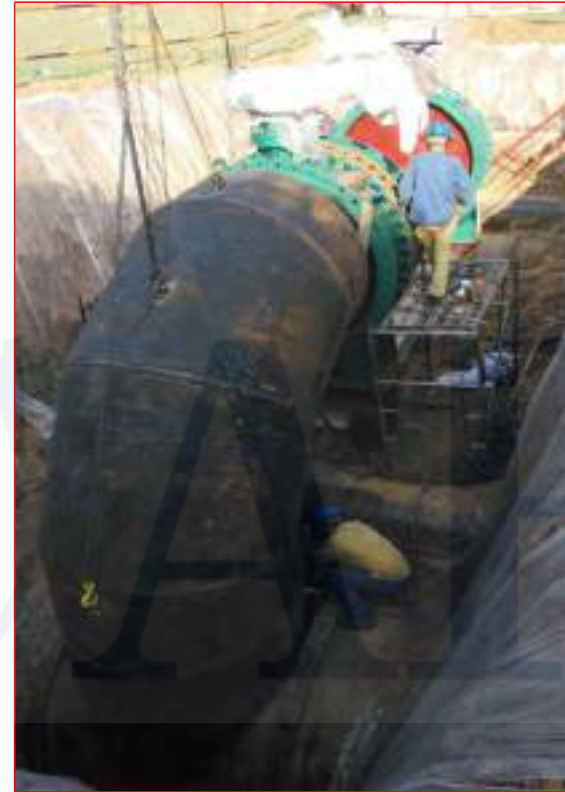
管道阀门安装
