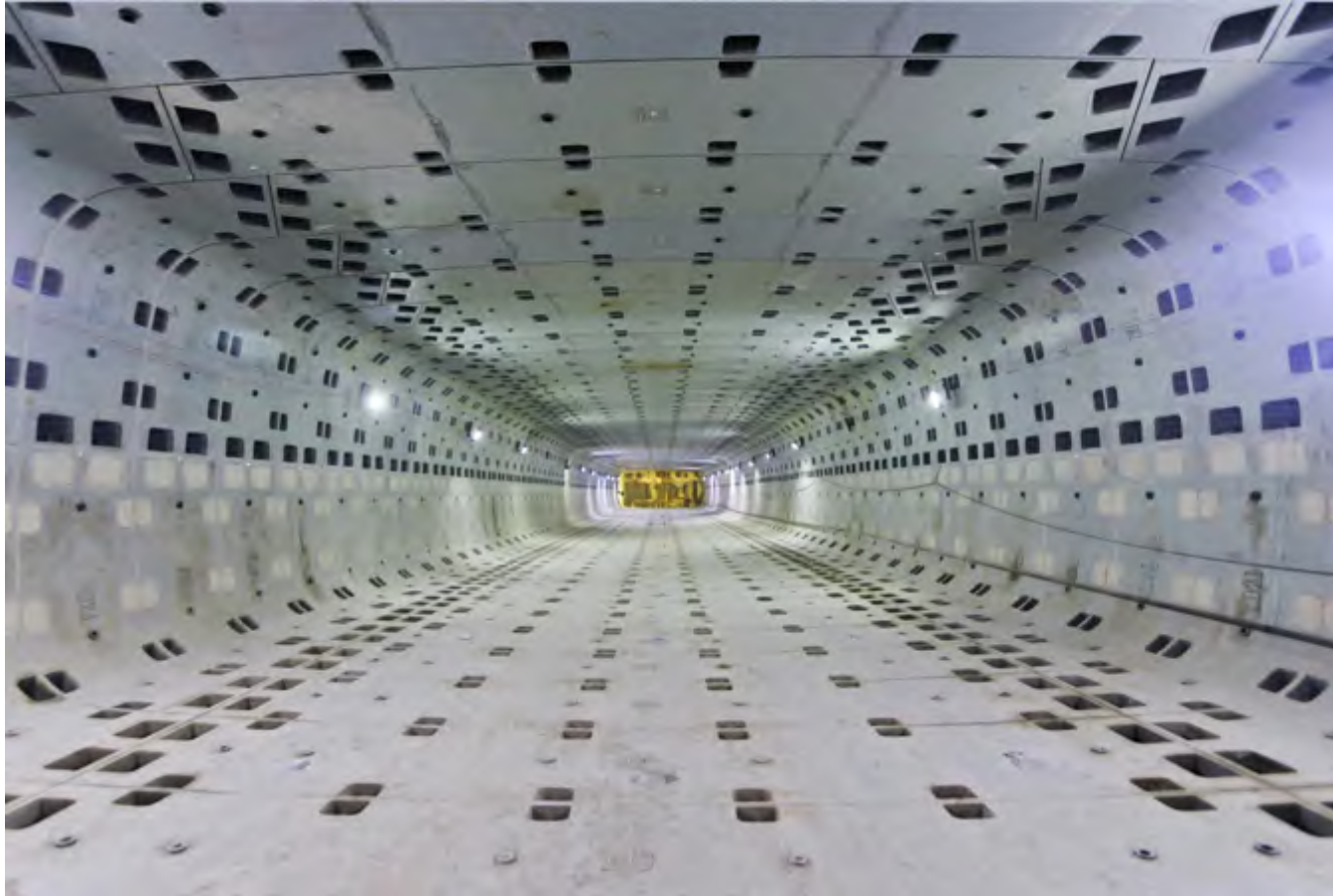
国内首条矩形盾构法隧道
