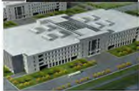
1 廊坊云数据中心
