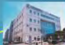
【上海松江】上海松江数据中心 8000㎡IDC, 4000机柜位
