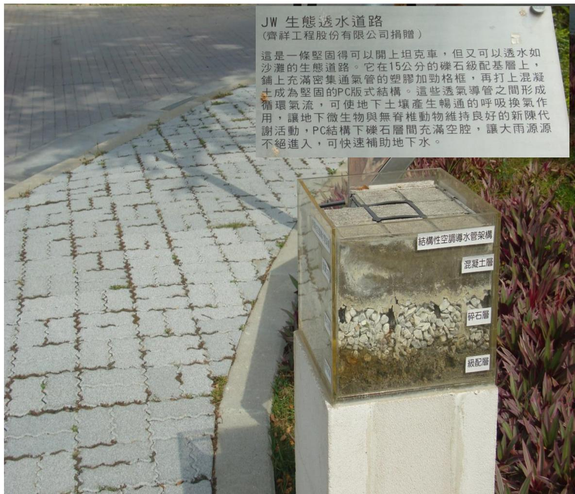
将停车场、广场、人行道、道路等人工铺面共约33平方公里改铺设高承载高透水铺面，并储存10cm雨水，则约增加3.3百万吨的储水，相当于增加6.6座大湖(是台北市最大的湖泊，储水约50万吨)。
