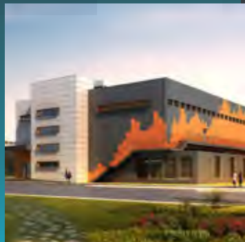
华北数据中心
