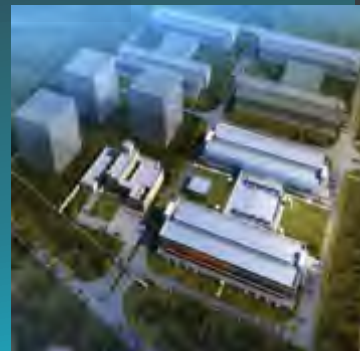
华北数据中心
