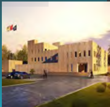
太阳能/风能数据中心
