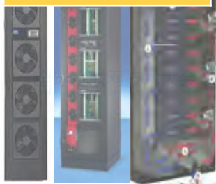
行级空调/机架自带冷却单元
