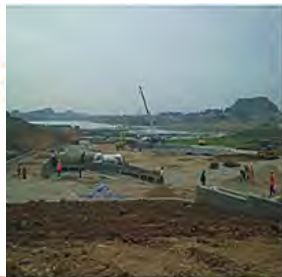
■ 建设中的月亮湖 Moon Lake under the construction
