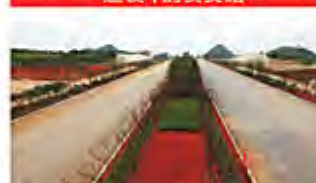
建设中的贵安路
